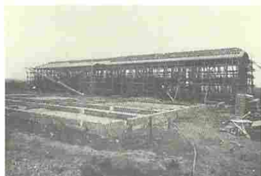
▲1号校舎の棟上、2・3号校舎の基礎工事
