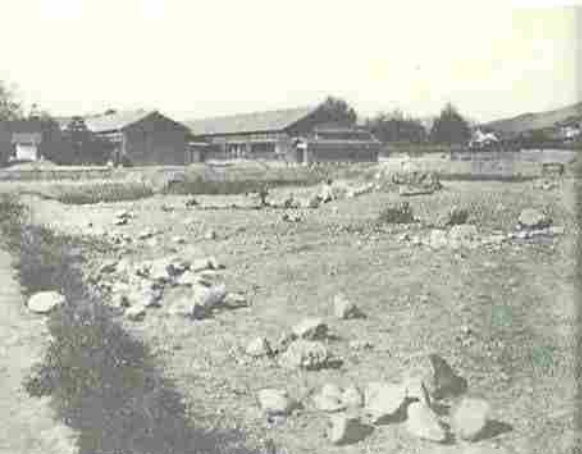
▲校舎建設・運動場拡張工事
