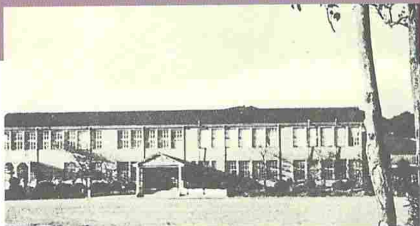
昭和26年に完成した本館
